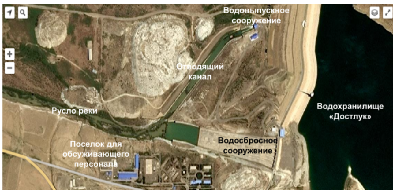
Рис.4. Вид водохранилища «Достлук», плотины и сооружений с космического снимка
