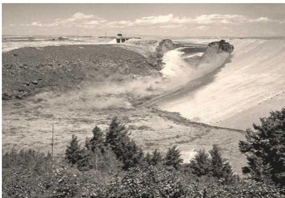
Рис. 6. Плотина Титон (США), фильтрация через породы основания и разрушение плотины, 1976 г.
