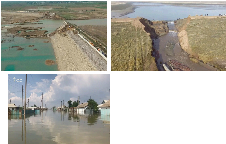
Рис. 8. Прорыв дамбы Сардобинского водохранилища в 2020 г. (Узбекистан)
