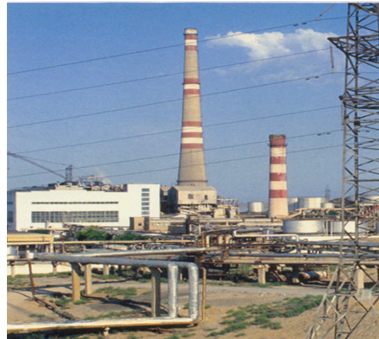
Тепловая электростанция в г. Туркменбаши
