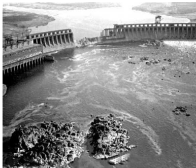
Рис. 5. Плотина Днепрогэс (Украина), 1941, 1943, 2023 г.
