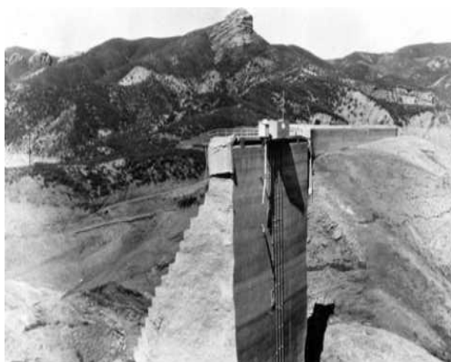
Рис. 3. Разрушение плотины Сент-Френси, 1928 г. США
