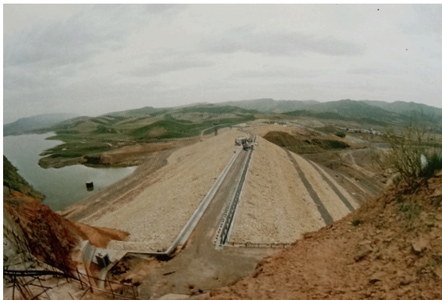
Рис. 3. Вид водохранилища «Достлук» и плотины со стороны Туркменистана
